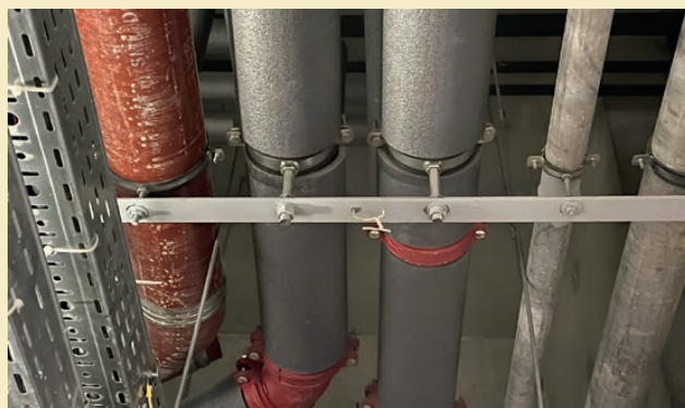
Применение хомутов тяжёлой нагрузки
