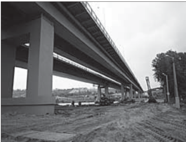
Рис. 3. Металлическое пролётное строение с цельносварными стыками наружных элементов Аксайского моста через р. Дон
